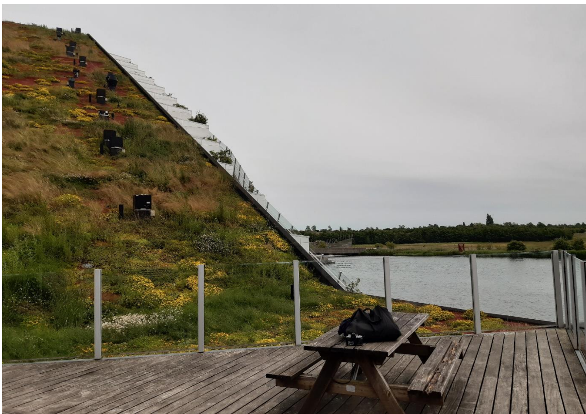
Fot. 9 „Zielony dach na budynku mieszkalnym” – Kopenhaga - Autor: Agnieszka Dudzińska – Jarmolińska
