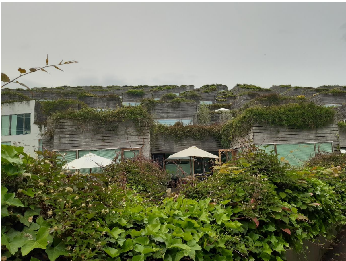
Fot. 12 „Zielony dach na budynku mieszkalnym” – Kopenhaga - Autor: Agnieszka Dudzińska – Jarmolińska
