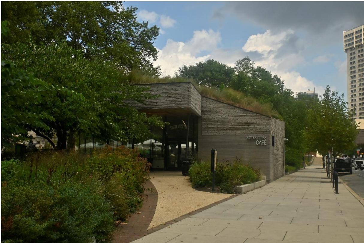
Fot. 20 „Zielony dach na budynku Sister Cities”– Filadelfia - Autor: Agnieszka Dudzińska – Jarmolińska
