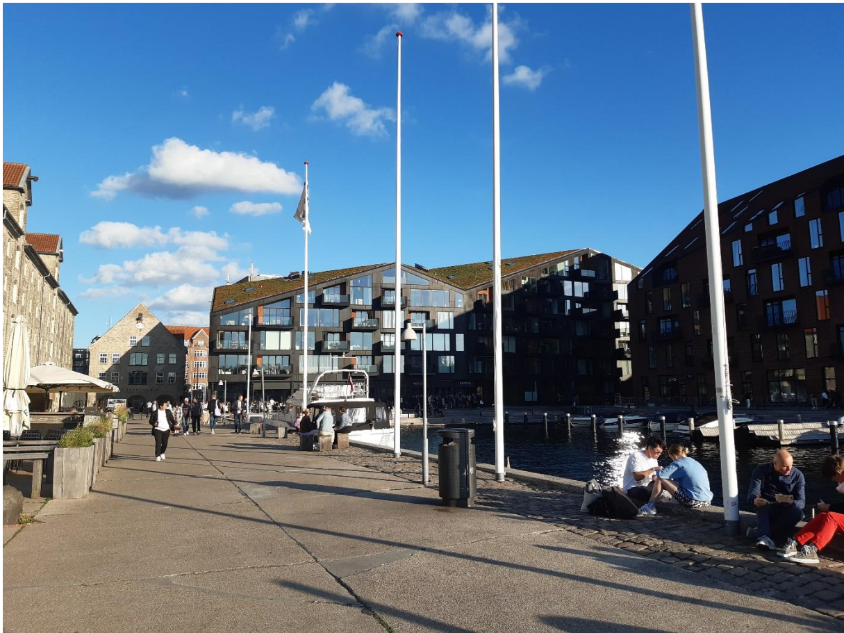
Fot. 8 „Zielony dach na budynku mieszkalnym” – Kopenhaga - Autor: Agnieszka Dudzińska – Jarmolińska
