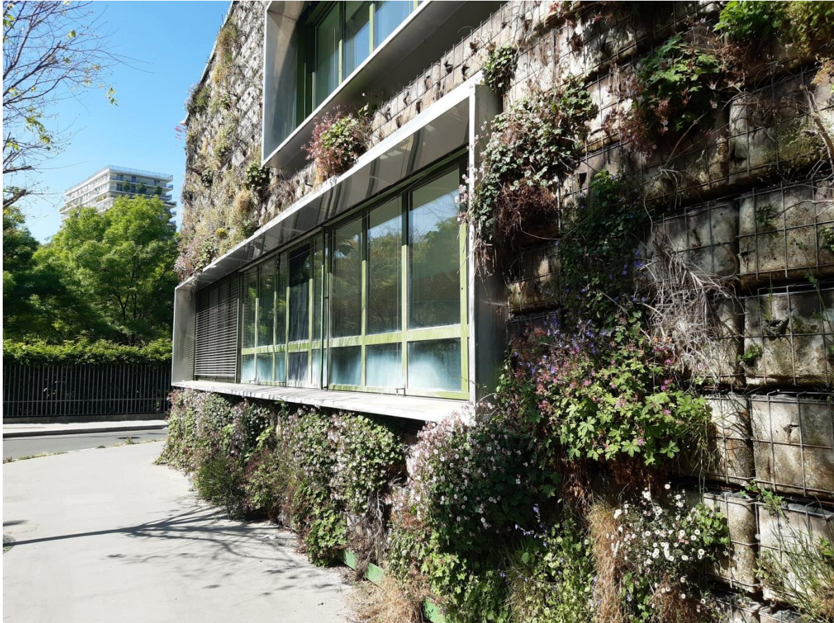
Fot. 3 „Zielona ściana modułowa przy Parc Clichy-Batignolles - Martin-Luther-King” – Paryż – zdj. Agnieszka Dudzińska – Jarmolińska
